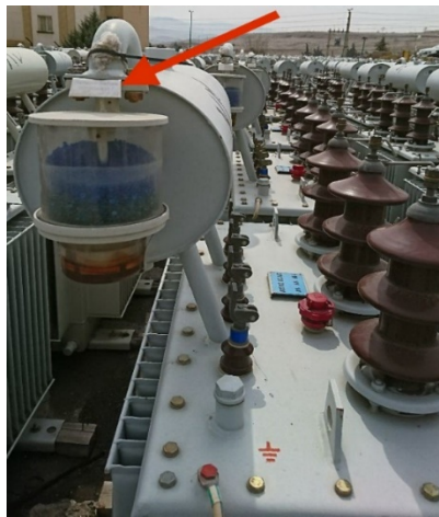
شکل ۸-۲۱- قطعه مسدود کننده رطوبت‌گیر
