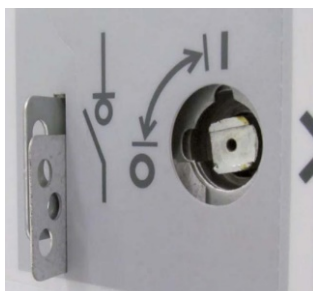
شکل ۷-۶- نمونه‌ای از به کارگیری ابزارهای قفل کننده جهت پیاده سازی اینترلاک در تابلو فشار متوسط
