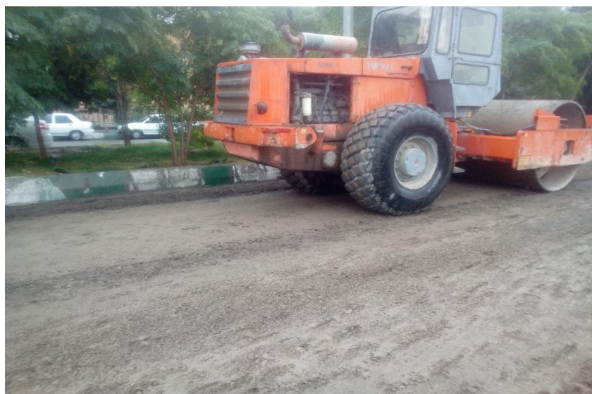
کمپکت نمودن سطح پروفیله شده با غلطک صاف به همراه ویبره
