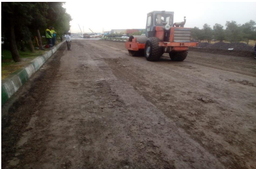
ادامه کمپکت نمودن سطح پروفیله شده با غلطک صاف بدون ویبره
